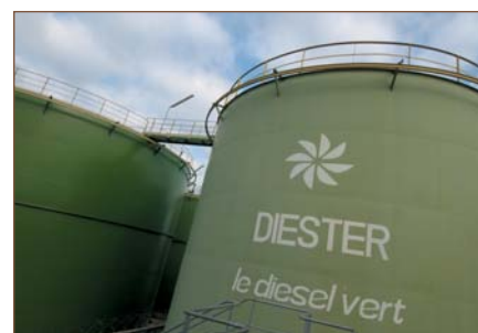
Cuve de diester
